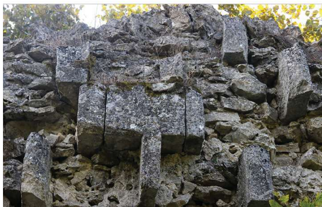
Рис. 6. Форт 7. Восточная куртина. Структура кладки стены Fig. 6. Fort 7. Eastern curtain. Masonry wall structure
